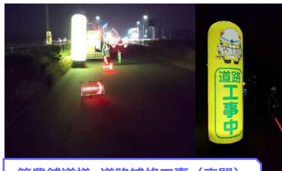
筑豊舗道様 道路補修工事(夜間)
